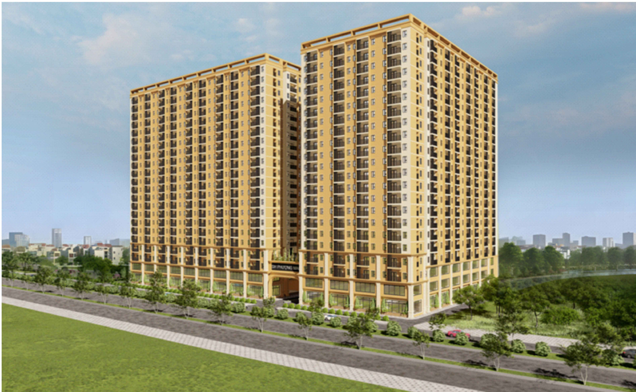
PHỐI CẢNH TOÀN NHÀ
